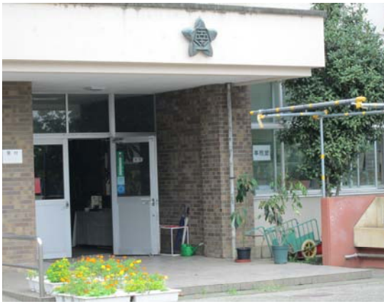
つつじが丘南小学校正面入口
